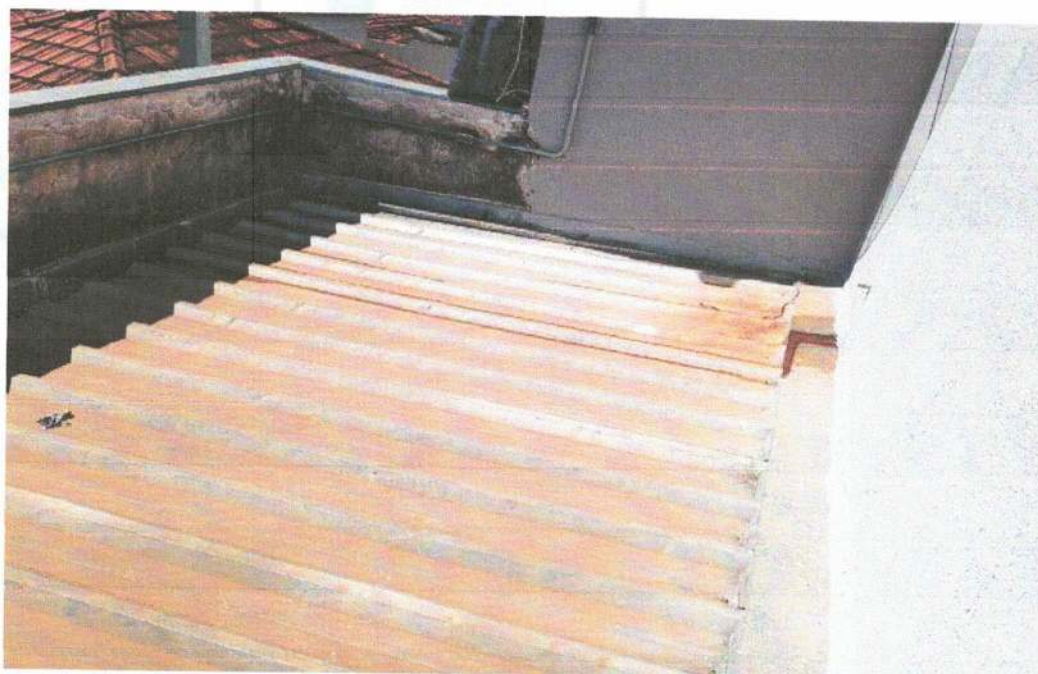
COBERTURA A SER SUBSTITUÍDA
