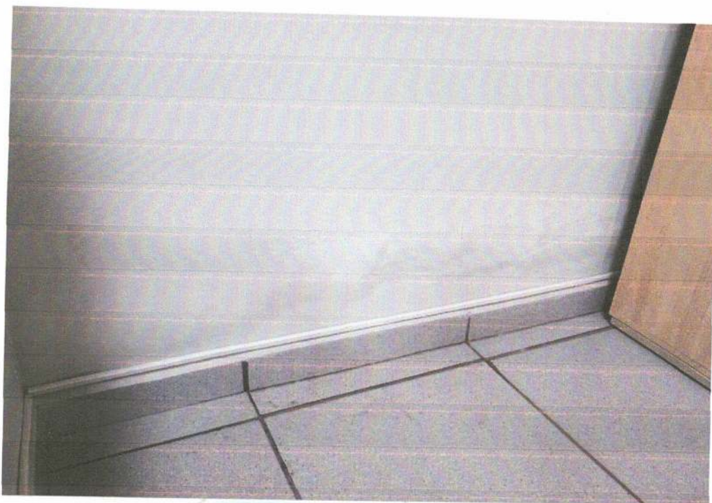
ALVENARIAS A SEREM IMPERMEABILIZADAS RECEPÇÃO
