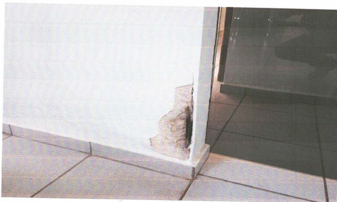
REPARO NA ALVENARIA (CANTO) QUE DIVIDE A RECEPÇÃO DA ÁREA ADMINISTRATIVA
