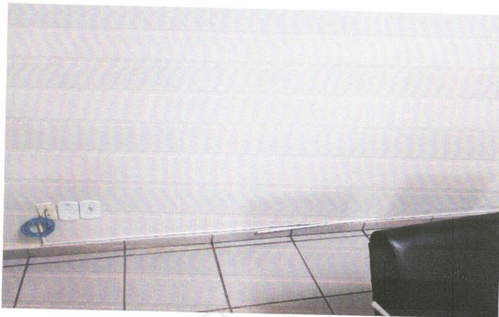
CABOS E FIOS A SEREM EMBUTIDOS NA ALVENARIA EM ELETRODUTO CORRUGADO
