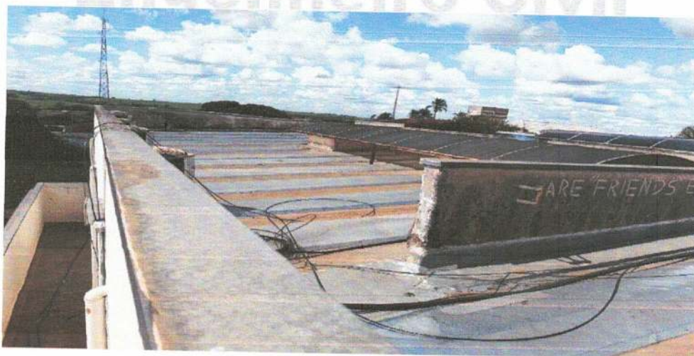
COBERTURA A SER SUBSTITUÍDA
