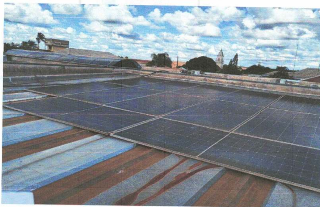
COBERTURA A SER SUBSTITUÍDA
