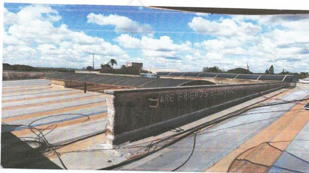
COBERTURA A SER SUBSTITUÍDA
