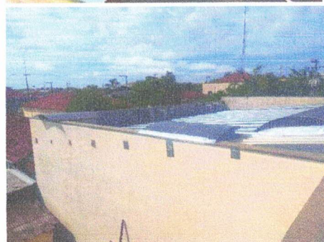
FOTO 25: PAREDE EXTERNA - COBERTURA
